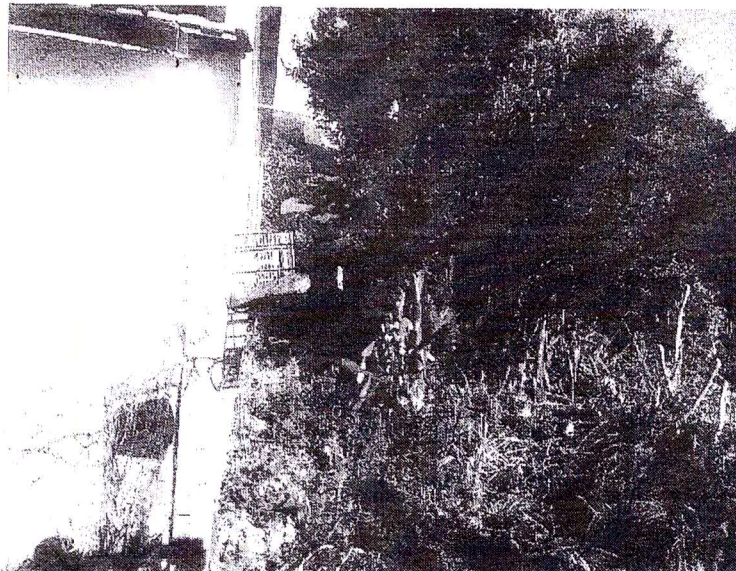
Imagem 3 – Área de desapropriação (Rua Virgínia Loss – Localizado entre os pontos P7 e P8, conforme projeto de levantamento)
